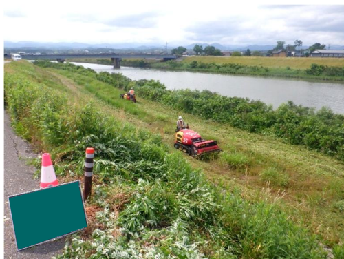
除草作業状況
