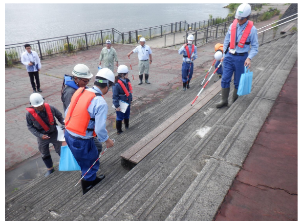
船着場点検状況【新潟市】
