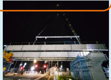
銚交差点付近の橋梁上部架設状況 (令和8年5月19日撮影)
