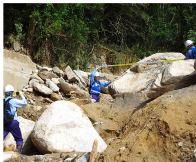
土砂災害被害状況の調査
