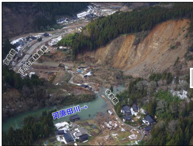
被災直後の様子 (令和6年1月撮影)
