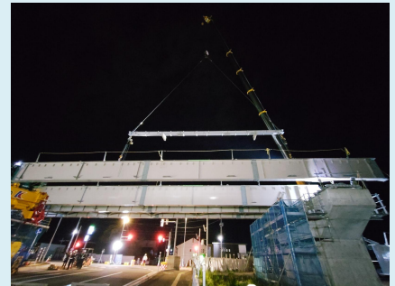
笠交差点付近の橋梁上部架設状況 (令和8年5月19日撮影)
