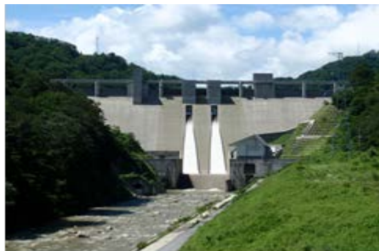
▲オリフィスゲートからの放流(6月16日以降の増水時) ダム正面(展望広場)から撮影
