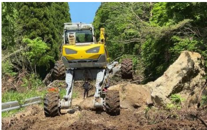
珠洲市道 726 号の道路啓開作業の様子 4本の脚で障害物を乗り越えて進入可能
