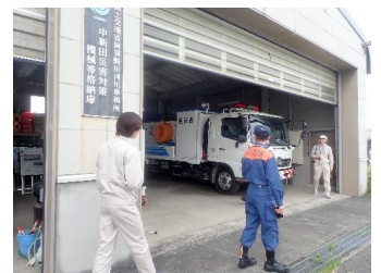
中新田災害対策機械等格納庫 （国土交通省管理）
