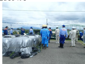
阿賀野市下里 （羽越本線鉄橋）
