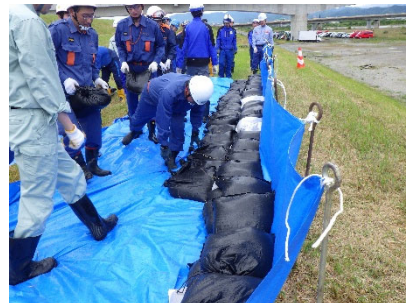
改良積土のう工
