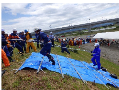
シート張り工
