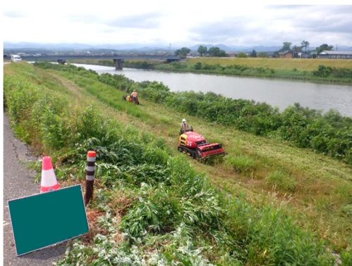
除草作業状況
