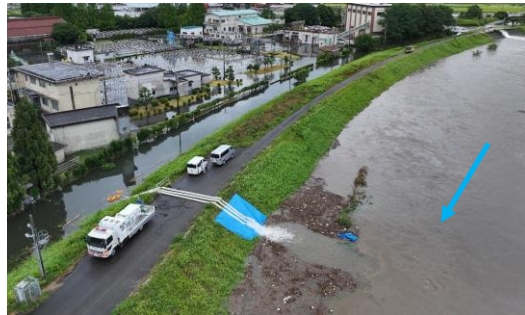
四谷排水機場 (小矢部川 (高岡市))
