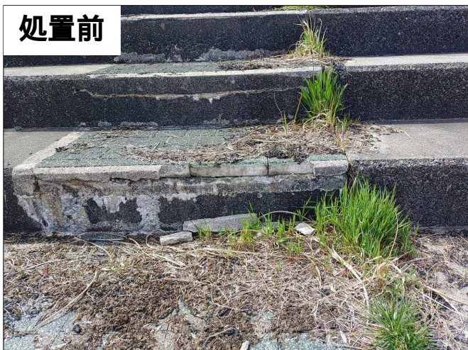
階段護岸の損傷箇所を補修
