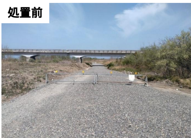
侵入防止柵の表示シートの交換
