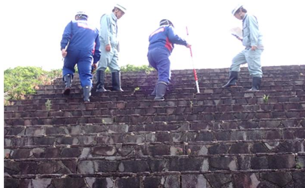
階段護岸で異常の有無を確認【射水市】
