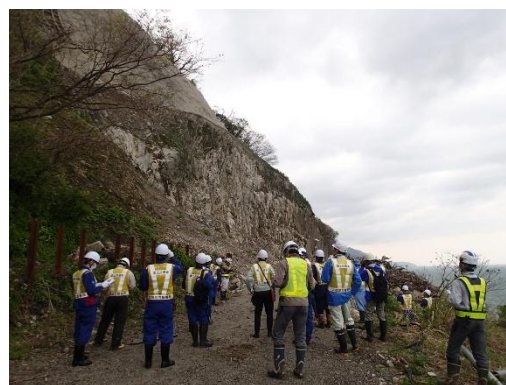
洞門上斜面の点検状況
