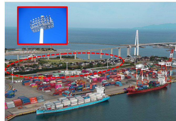
ヤード内の L E D 照明
