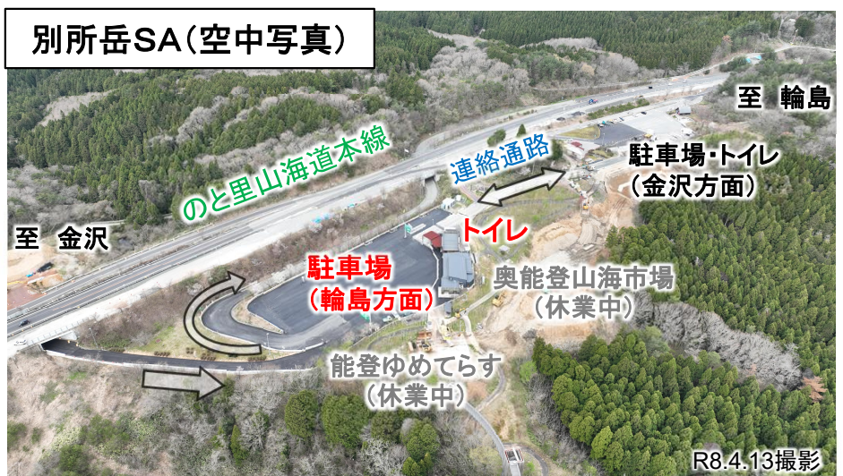
別所岳SA(駐車場(輪島方面)復旧状況)
