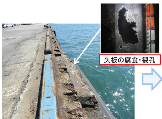
改良前の2号岸壁 （上部コンクリートの欠損、鉄筋露出）
