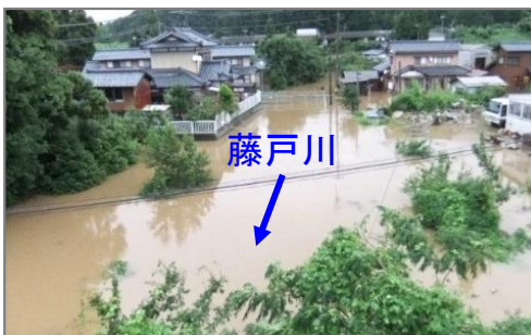
H23. 7 浸水被害の状況
