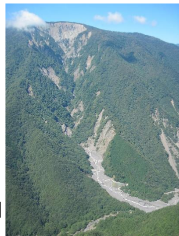
写真 七面山の大崩れ
