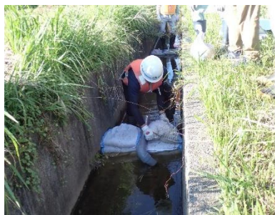
【訓練】土のう積み訓練
