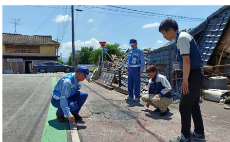
道路の被災状況調査(八代市)
