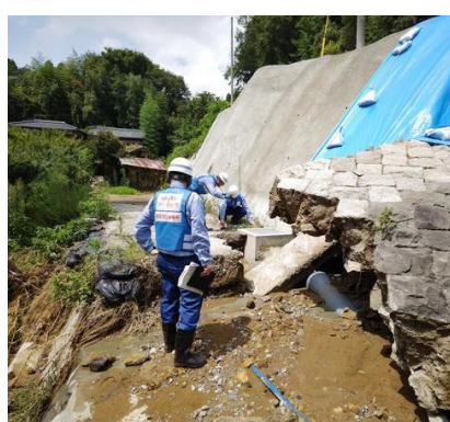
道路法面の被災状況調査 (千葉市)
