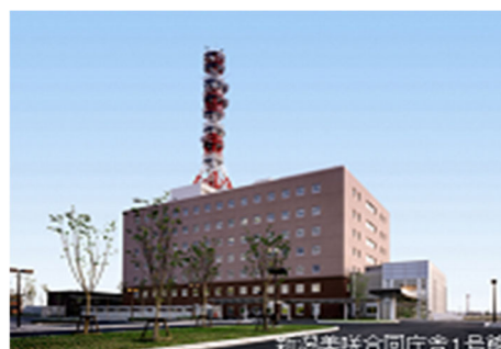
新潟美咲合同庁舎1号館
