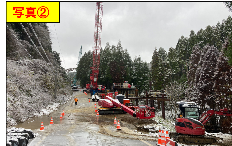
中屋トンネル輪島市街地側における仮橋施工状況(R6.12)
