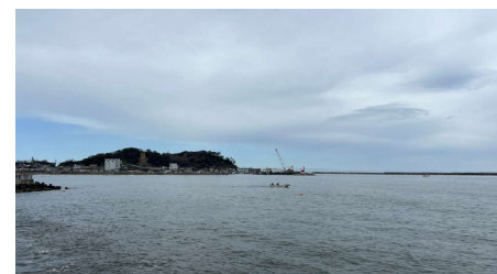
緊急浚渫完了 (R7. 4. 10浚渫完了)
