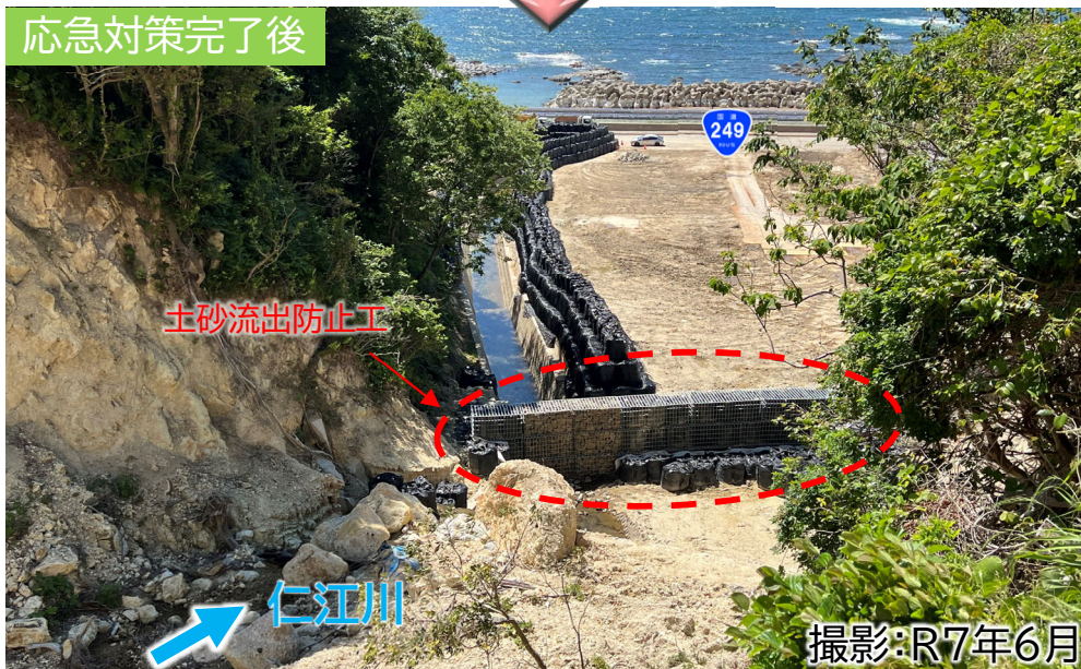
仮設護岸工の整備状況
