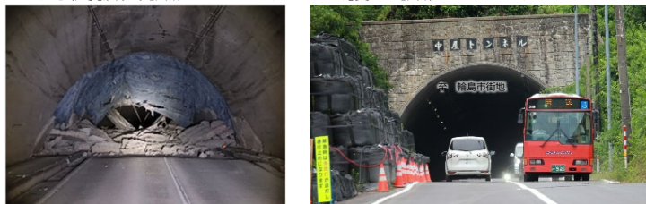
①中屋トンネル工区 (地震被災状況 R6.1) (復旧状況 R7.7)
