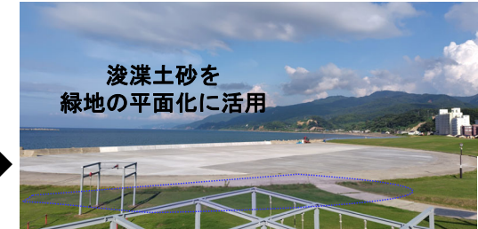
連携により土砂を有効活用
