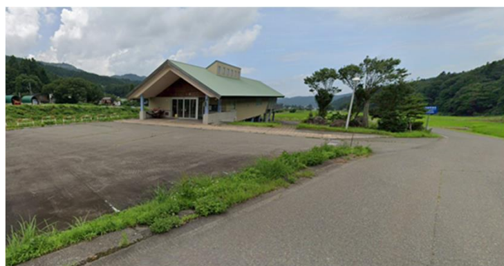
駐車場: 会館正面
