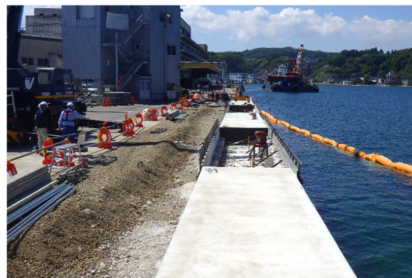
上部工(上部コンクリート打設)
