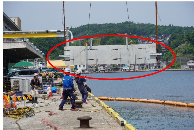
本體工(※残置型枠設置)
