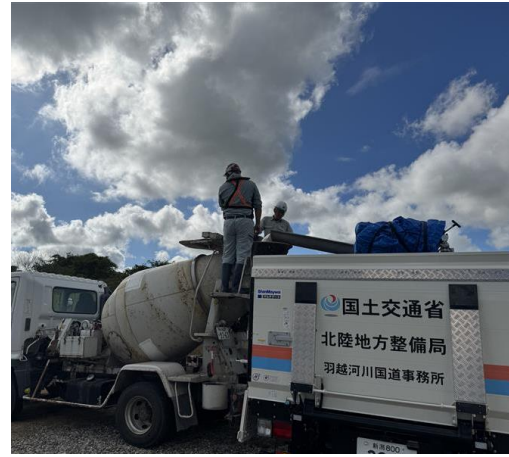
積込状況 (コンクリートミキサー車)
