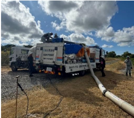
河川水のくみ上げ状況 (排水ポンプ車)
