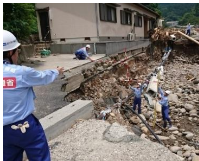
河川被害状況の調査
