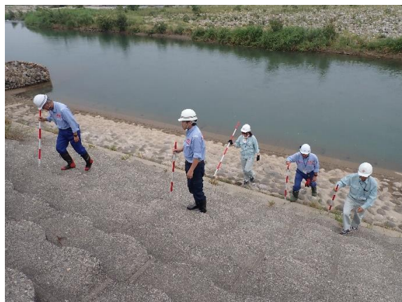
親水護岸の点検状況（富山県：神通川）
