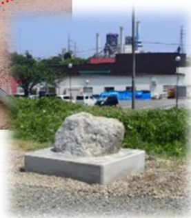
建立する石碑 （写真は作業中のものになります。）
