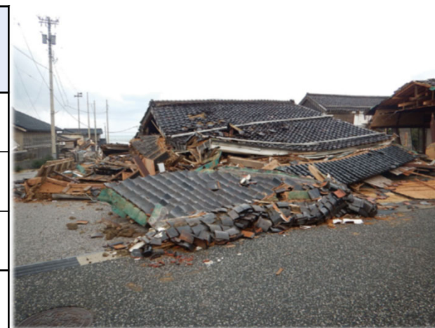
〔建物の倒壊(輪島市)〕
