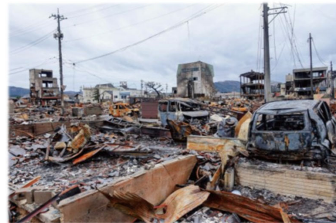
〔輪島市内の火災被害〕
