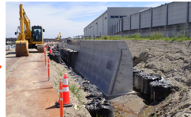
本復旧状況（直立堤施工）（R7.5）
