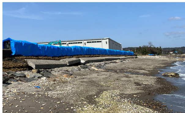
大型土のう・ブルーシート等設置による応急復旧（R6.4）
