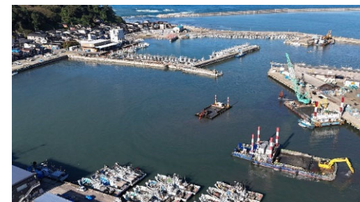
漁船だまり浚渫状況 (令和6年10月21日)
