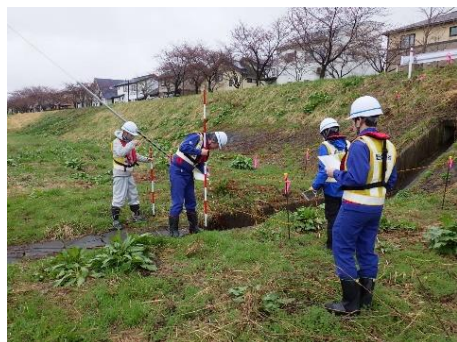
令和7年度大型連休前の点検状況 （湯川村親水護岸）
