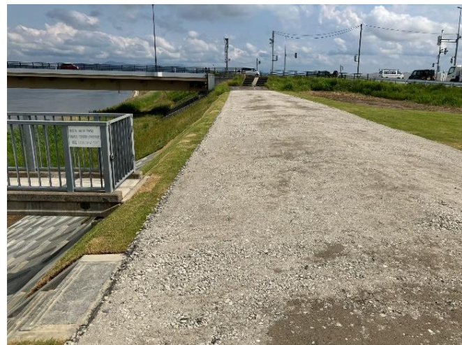
完成（亀裂修繕状況）
