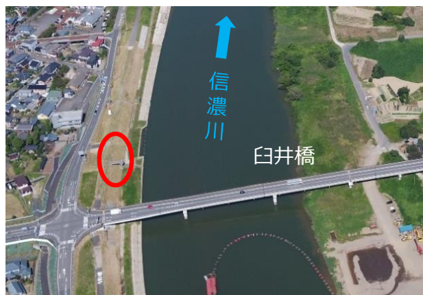
堤防亀裂発生箇所（庚塚取水樋管付近）
