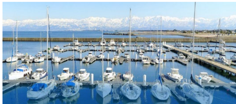
伏木富山港(ボートパーク事例)
