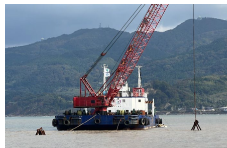
起重機船（弘武）による緊急浚渫状況
