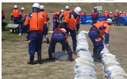
積み土のう工
