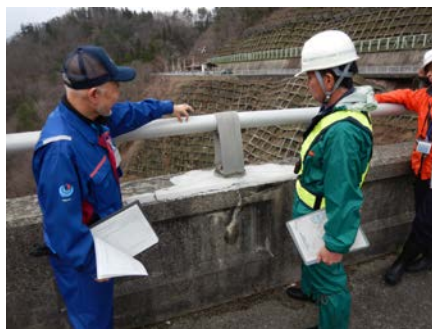
(大石ダム天端・関川村)
