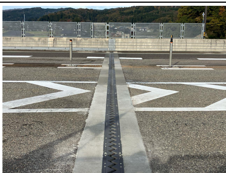
橋梁の補修状況
