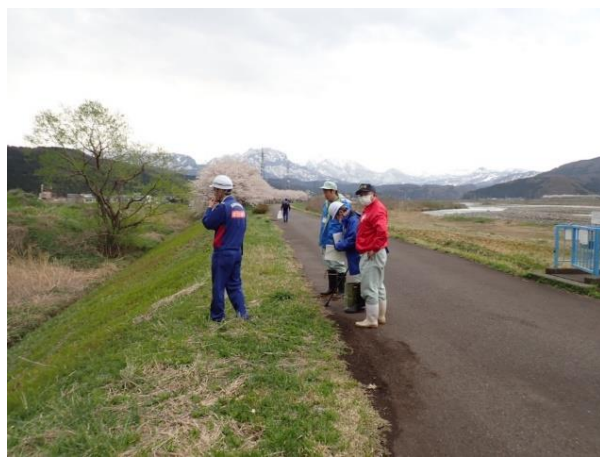
点検状況（姫川）
