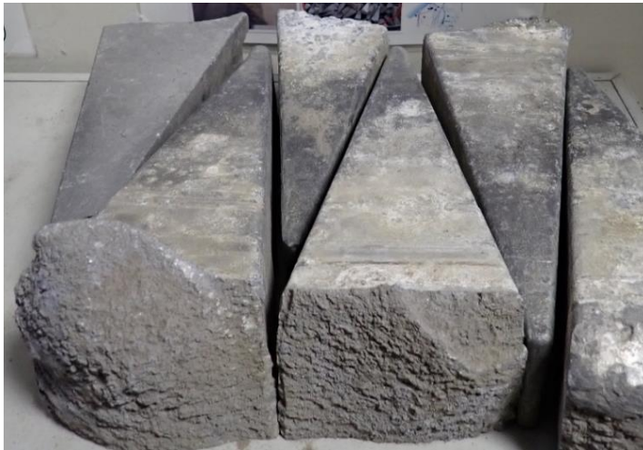
(粉々に砕けた鋼製のジョイント)
