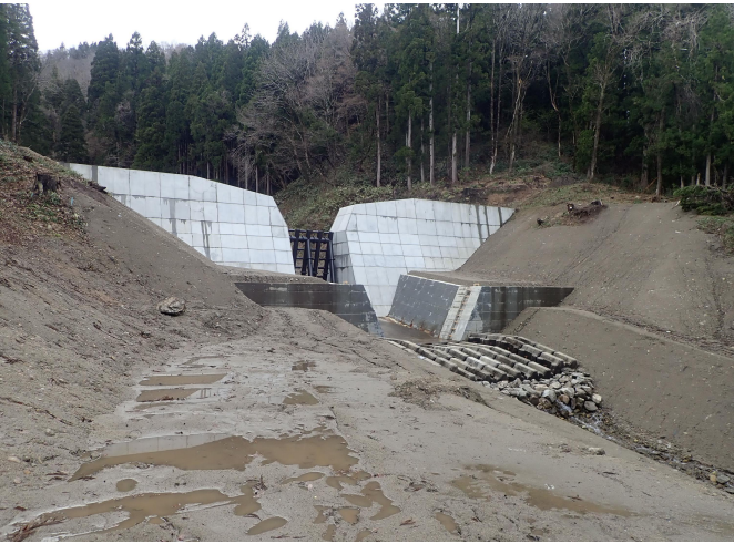
横山沢上流砂防堰堤完成 （令和7年4月撮影）
