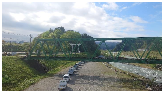
進入口の状況
