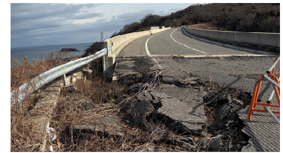
写真④: 烏川大橋
