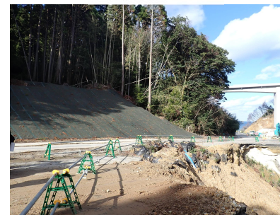
写真③: 工事用道路
