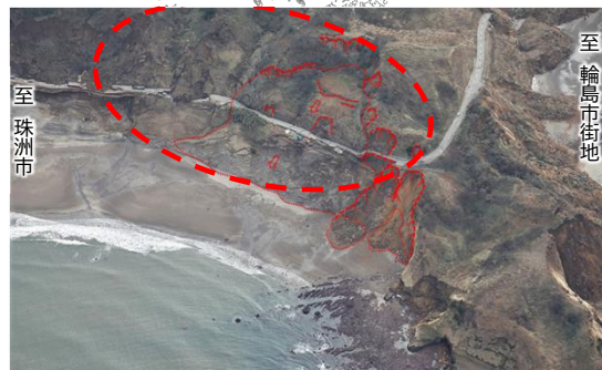
写真① 地震による地すべり・斜面崩壊
