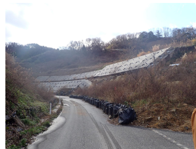
写真②: 工事用道路
