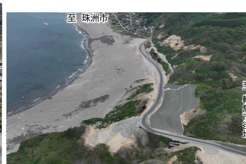
写真③ 応急復旧道路
