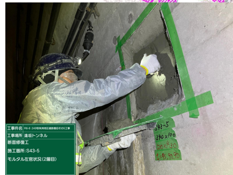
写真②: 既設トンネル補修
