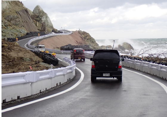
写真① 令和6年12月27日(金)1車線通行確保
