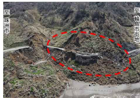
写真② 地震による道路決壊を伴う地すべり
