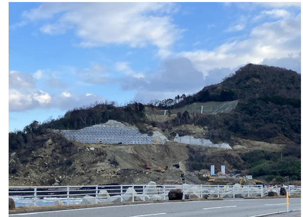
写真③: 頭部排土+アンカー工
