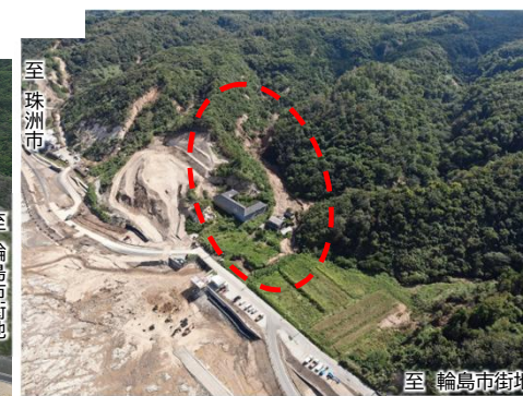
写真④ 豪雨による土砂流出
