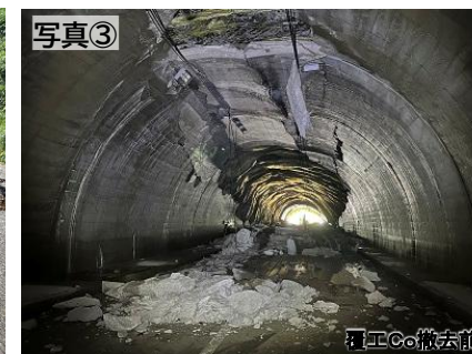
覆工Co、支保工の被災調査状況
