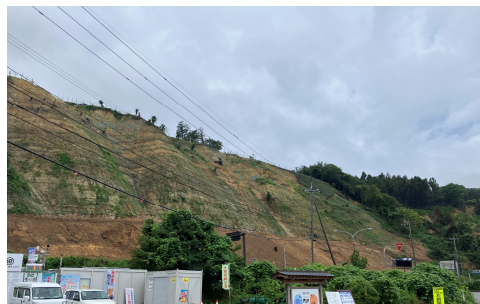
写真①: 斜面对策工事
