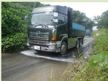
工事用車両のタイヤ洗浄状況
