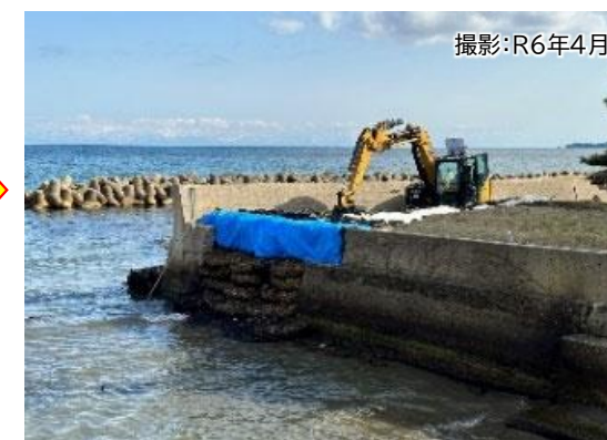
袋詰玉石、大型土のう敷設完了
