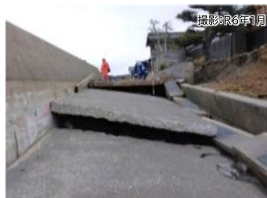
護岸・水叩き損傷
