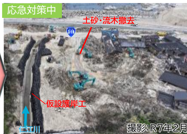
土砂・流木撤去(応急対策)【国】と公費解体【市】の作業状況
