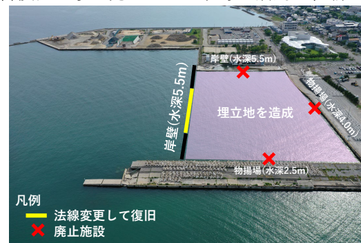
飯田港岸壁(水深5.5m)の復旧
