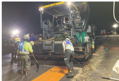
夜間工事で復旧を進める
