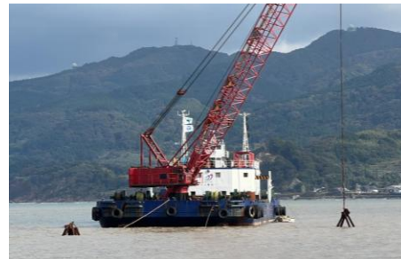
起重機船（弘武）による緊急浚渫状況
