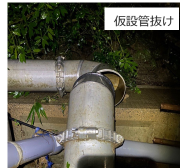
<輪島市 仮設送水管と付近の道路の被害状況>
