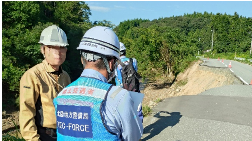
道路班 (珠州市)
