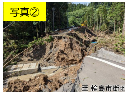
門前地区方面を望む (R6.9.23_14時撮影)
