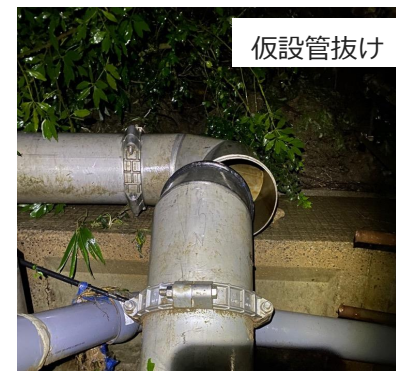
<輪島市輪島浄水場から第1配水池への仮設送水管と付近の道路の被害状況>
