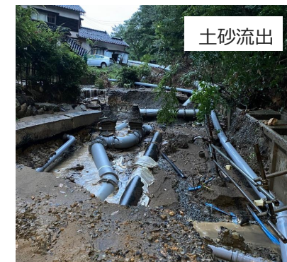
<輪島市輪島浄水場から第1配水池への仮設送水管と付近の道路の被害状況>
