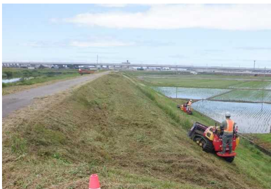
除草作業状況
