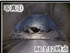
写真① 国道249号中屋トンネル (中屋トンネル工区)
