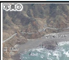
写真③ 国道249号輪島市町野町大川～浜田町 (大川浜工区)
